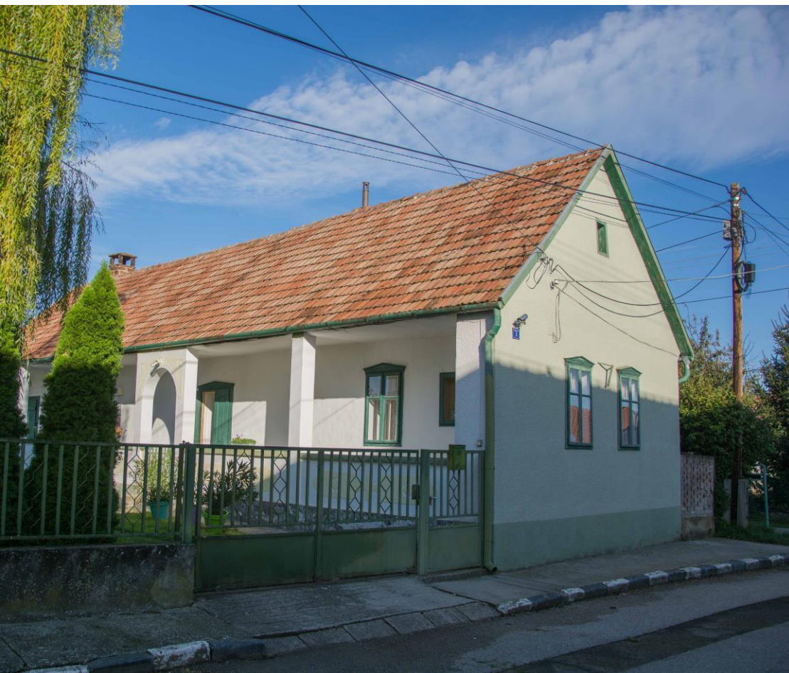
A homlokzaton a nyílászárók osztása és aránya is egy védendő érték.
